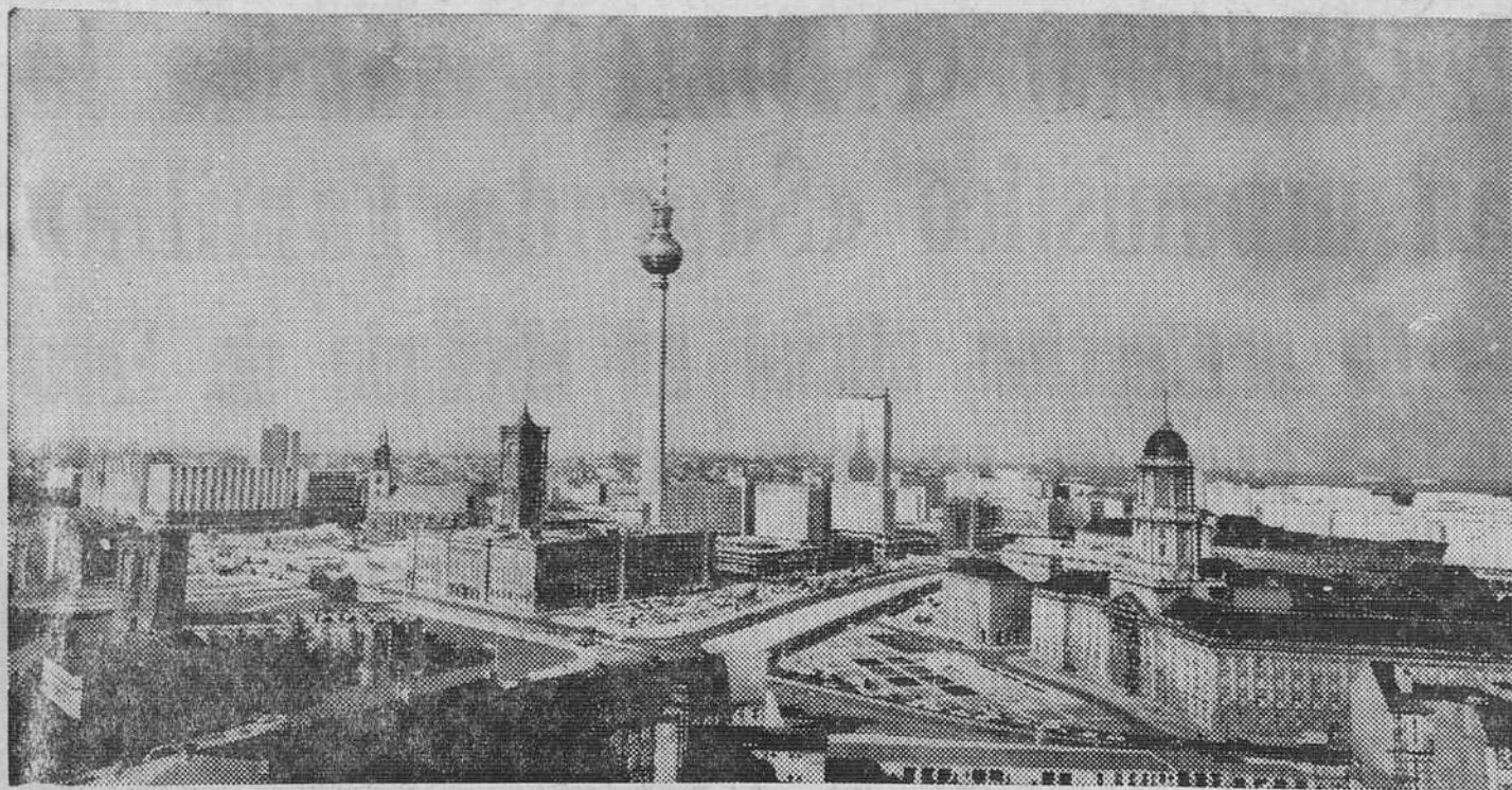
1945: 20 millones de metros cúbicos de escombros cubren Berlín. Sus barrios ofrecen un aspecto desolador. 1969: un nuevo Berlín se ha levantado sobre aquellos escombros y grandes edificios ofrecen un nuevo aspecto de la antigua capital alemana. Esta fotografía muestra una vista general del sector oriental, con la nueva Torre de la Televisión en el centro. — (Foto FIEL).
