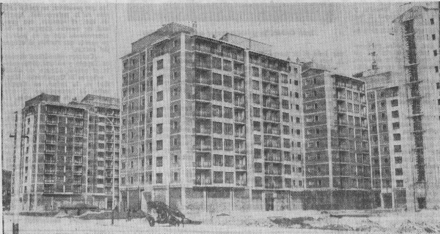
Obras de urbanización en el polígono «Sagrada Familia»
