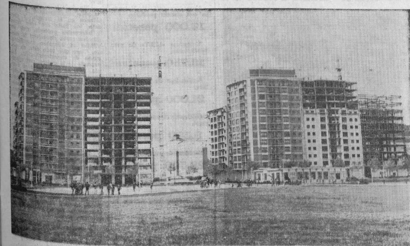
Nuevas edificaciones en la Avenida del General Vigón
