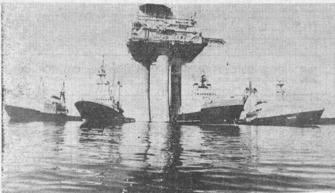
Esta es la nueva plataforma «Beryl A» que ha situado en Stavanger (Noruega) la Compañía Mobil Oil. Es la primera de una nueva generación de estructura de hormigón, de 350 toneladas y sustentada por tres torres. Será utilizada para la extracción de petróleo con destino a Gran Bretaña. — (Foto FIEL).
