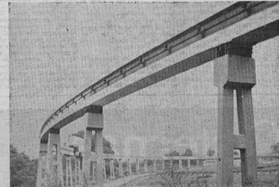
Un nuevo tipo de monorail probado por una pareja de ingenieros alemanes cerca de Colonia. El aparato capaz de 80 mph ha sido encargado por la ciudad de Sao Paulo, Brasil. En nuestra foto el nuevo monorail en un ensayo cerca de la ciudad de Colonia. — (Foto San Antonio - European Press).
