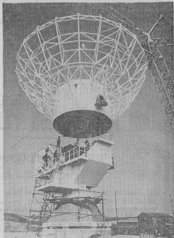
A partir de 1977, todo lo que capte esta antena con su enorme «oreja» de quince metros podrá contribuir a una mejor predicción del tiempo en Europa. El satélite meteorológico «Meteosat», de la European Space Agency, situado a 36.000 kilómetros sobre el ecuador, tomará cada media hora fotografías de la zona comprendida entre la Europa del Norte, el Atlántico y el Océano Índico, y las enviará a una estación terrena, en Alemania, con otros datos, para que una computadora realice las correspondientes previsiones. — (Foto FIEL).
