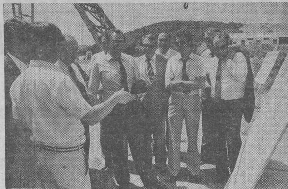
Escuchando las explicaciones sobre el proyecto de la presa, en el lugar donde se ubicaría la obra. — (Foto FEDE)
