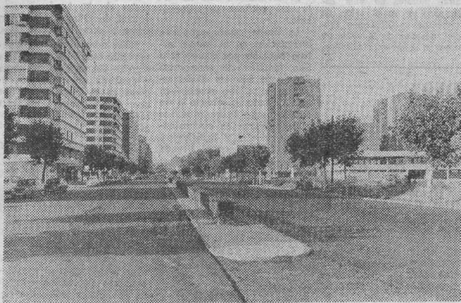
Están a punto de concluir las obras de mejora del firme de la avenida del General Vigón y las máquinas de la Jefatura Provincial de Carreteras se disponen a rematar esta importante mejora. — (Foto FEDE).
