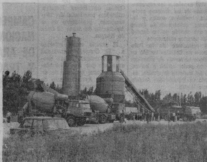
Panorámica de las instalaciones que "Hormigones J. Martínez" acaba de inaugurar en el Polígono Industrial "LA VEGA", de Briviesca. La planta está servida por numerosa flota de vehículos.
