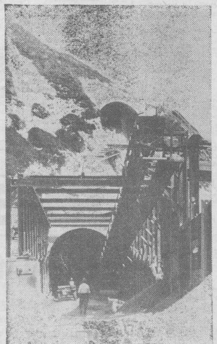
La entrada del túnel de 287 metros (arriba) cavado en el acantilado Shakespeare, cerca de Dover, que permitirá el acceso de los obreros y del material por carretera en un lugar situado al pie del acantilado. El túnel del primer plano, de unos 1.400 metros de longitud, permitirá el acceso al lugar donde se iniciarán los trabajos del túnel propiamente dicho del canal de la Mancha.
