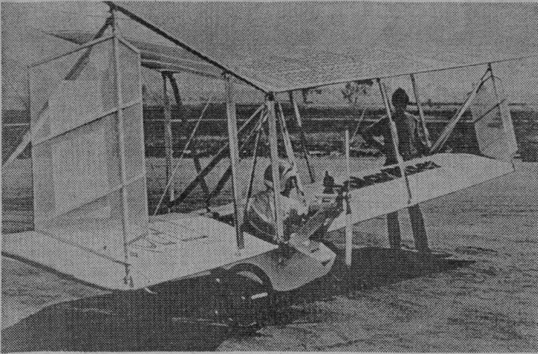
Riverside (California). — El piloto Larry Mauro da la señal de "preparado" desde la carlinga de un pequeño aeroplano impulsado por energía solar, construido por él mismo después de sucesivas pruebas en el aeropuerto de Flaboi, en Riverside. Las células solares que impulsan a los motores están colocadas en el extremo de las alas. El aeroplano se mantuvo en el aire durante un minuto. — (Telefoto EFE-UPI).
