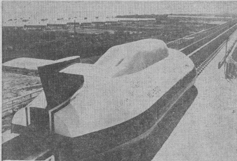
Hyuga (Miyazaki, Japón). — La máquina experimental de los Ferrocarriles Japoneses, con motor a propulsión, dispone de cola, como los aviones, para mantener mejor su nivel, dura te los recorridos a grandes velocidades. Su velocidad es de 500 kilómetros por hora. — (Foto EFE).
