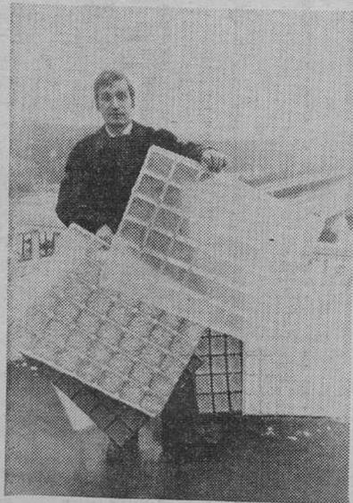
Stuttgart (DaD). — Muy livianas, transparentes e impermeables son las planchas de plástico antirruído que nos muestra su inventor, el ingeniero alemán del Instituto de Física Fraunhofer, de Stuttgart, Norbert Kiesewetter. Absorben o «destruyen» el 80 por ciento de la energía acústica. Son ideales para viviendas ubicadas en lugares de mucho tránsito o junto a carreteras. — (Foto DaD).
