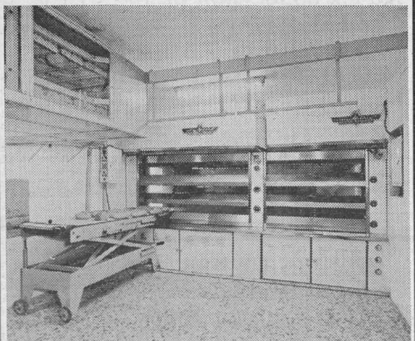
HORNO PISOS SUPERPUESTOS DE 27 METROS CUADRADOS, CON CARGADOR AUTOMATICO
