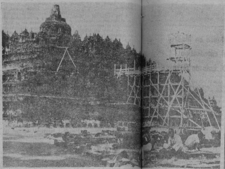
Vista parcial del Templo de Borobudur con los andamios de restauración para fortalecer los elementos de la estructura en peligro de derrumbo o degradación. (Foto HISPANIA PRESS).
