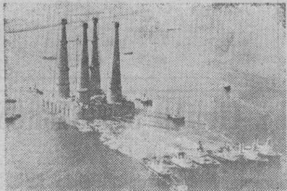
Rotterdam. — En la foto, más de una docena de remolcadores, con una fuerza de 100.000 HP, remolcan la plataforma petrolífera ANDOC, desde el puerto de Rotterdam a alta mar, a una velocidad de dos kilómetros-hora. La ANDOC, de 144 metros de altura y 100 X 100 metros de base, será terminada en Noruega. El próximo año empezará a perforar en el Mar del Norte y se cree que producirá diez millones de toneladas anuales de petróleo por encima del nivel del mar. — (Telefoto UPI-CIFRA GRAFICA).
