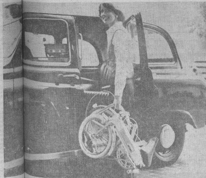
La Compañía Británica ha fabricado una bicicleta portátil, original y de poco peso, que acaba de ser lanzada al mundo. Es la bicicleta más ligera del mundo (8 kilos) construida en una aleación de aluminio, se puede plegar en 40 segundos y es fácil de llevar en una bolsa. Su diseñador es Harry Bickerton, antiguo ingeniero de Rolls-Roice y De Havilland. — (Foto FIEL)
