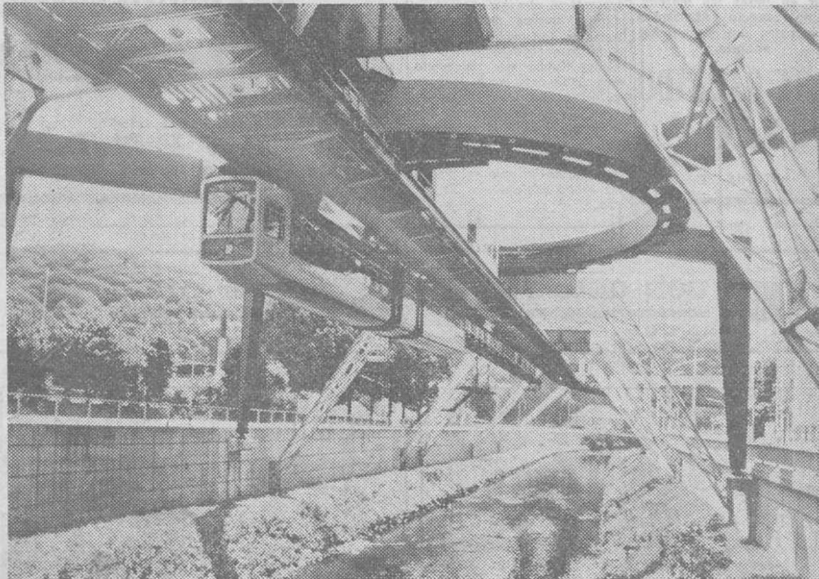
Düsseldorf. — El ferrocarril aéreo de Wuppertal (República Federal de Alemania), será más seguro en el futuro con la nueva instalación de inversión, ya que permite mantener el tráfico en tramos de la línea general, de trece kilómetros de longitud, incluso en caso de averías. En la línea muerta de la instalación de inversión, a 14 metros de altura, pueden "aparcar" dos trenes. Los trenes pueden ponerse en marcha y frenar con un proceso de inversión de tan sólo 90 segundos. — (Foto DaD).
