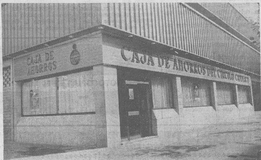
FACHADA DE LA NUEVA OFICINA EN EL CENTRO COMERCIAL "SAN BRUNO"
