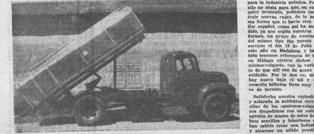
Otra vista del camión-volquete del Servicio Municipal de Limpieza, cuya caja, basculante y enteramente de aluminio ha sido construída por "Talleres Rosan", del Paseo de los Pisonés 19.
