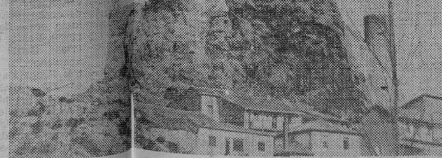
Estos son los últimos trabajos del paisaje actual del castillo roquero de Frías. Las obras están a punto de terminar en el recinto de la fortaleza. Para Primavera posiblemente terminarán todos los trabajos.
