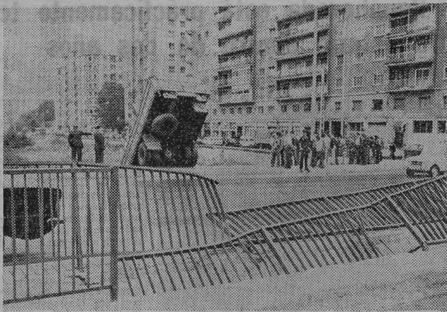
Otro plano gráfico del aparatoso accidente registrado en el puente de la "Autovía de Ronda", sobre el Arlanzón. Muestra una perspectiva de la zona donde ocurrió el siniestro y en ella puede verse el estado de la barandilla central y de la principal del puente, ambas rebasadas por el vehículo santanderino. — (Foto FEDE)
