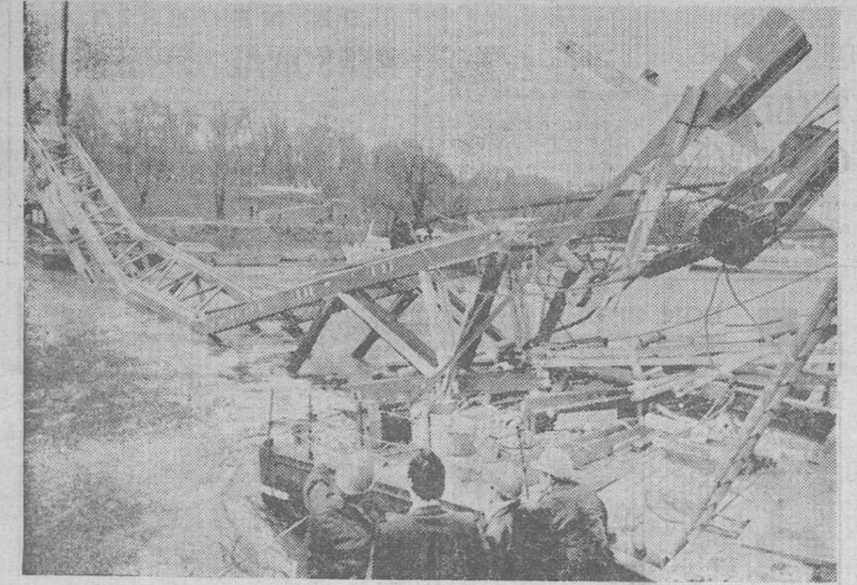
Stuttgart (Alemania Occidental). — Expertos en la construcción inspeccionan el estado en que quedó el puente de madera de 157 metros de largo que cruza el río Neckar, después de derrumbarse a las pocas horas de haber sido acabado. Todavía no se conocen las causas por las que se ha derrumbado este puente, sin estronar. No hay que lamentar desgracias personales. El puente se había construido para dar un sabor rústico a la Muestra de Jardinería de Stuttgart. — (Telefoto CIFRA GRAFICA-UPI).
