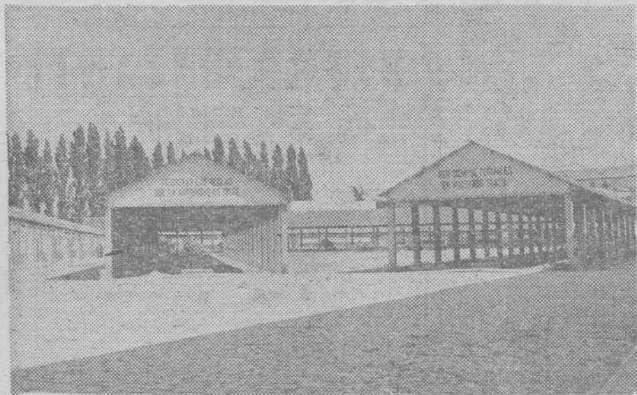
Así eran las instalaciones del mercado de San Lucas, que contaba con pabellones para el ganado, como los que muestra la fotografía. — (Foto FEDE)
