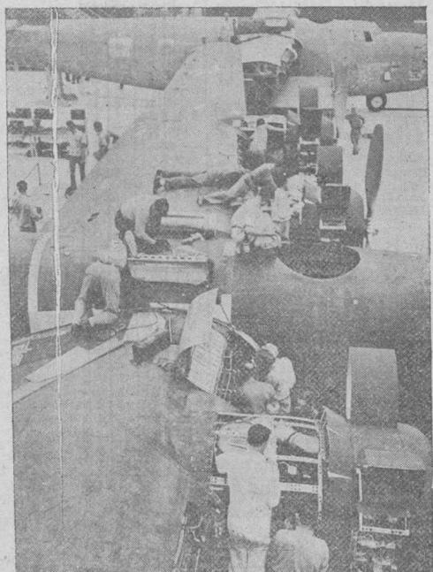
En una fábrica de aviación de Estados Unidos, donde se han construido los mayores bombarderos, los B-24, estos operarios proceden a ultimar la colocación de las diversas piezas complementarias de los motores que van instalados en las alas
