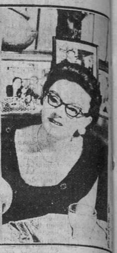
Nueva York. — Esta señora luce gafas especiales que facilitan la audición de los sordos. En una de sus patillas lleva montado el mecanismo que, muy simplificado, elimina el cordón, el micrófono y el amplificador de la oreja. Lleva una batería eléctrica para 150 horas de duración y la cual puede recargarse por 40 centavos. (Foto Cifra)
