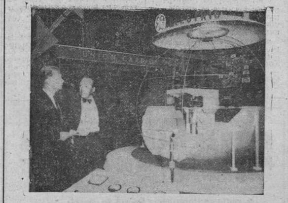
Este modelo de reactor de agua en ebullición, que genera vapor para las turbinas que hay dentro del mismo, reducirá los costes para las pequeñas centrales atómicas eléctricas. Un reactor de este tipo producirá hasta 200.000 kilovatios y costará unos 45 millones de dólares (unos 180 de pesetas). Un reactor de esta clase se está construyendo actualmente en Chicago, Illinois y se espera que esté terminado para 1960.
