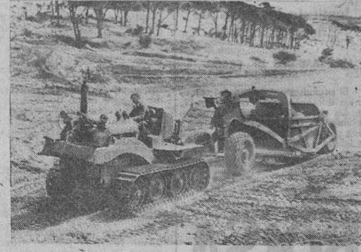
Semejante a un carro de combate ligero, el "Vikon" es uno de los tractores oruga más poderosos del mundo, capaz de desplazar de un golpe dieciséis toneladas de tierra. En la foto está siendo utilizado para la explanación de los terrenos donde se construirá un campo de deportes, cerca de El Cabo. (Foto "Gil del Espinar")
