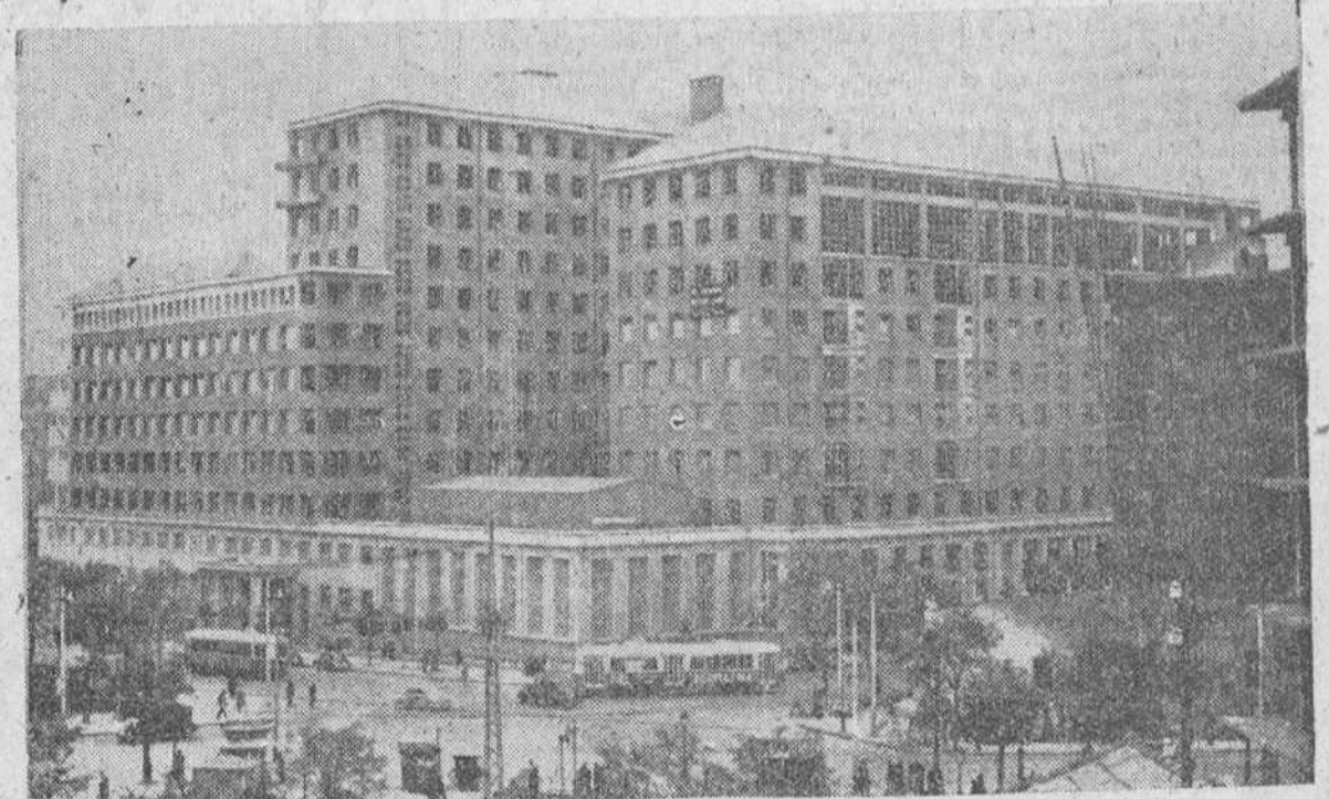
Vista general del nuevo hospital de la Beneficencia general, que abrió sus puertas en el mes de Noviembre del pasado año. Consta de mil camas y su coste se ha elevado a los cien millones de pesetas. — (Foto Archivo).
