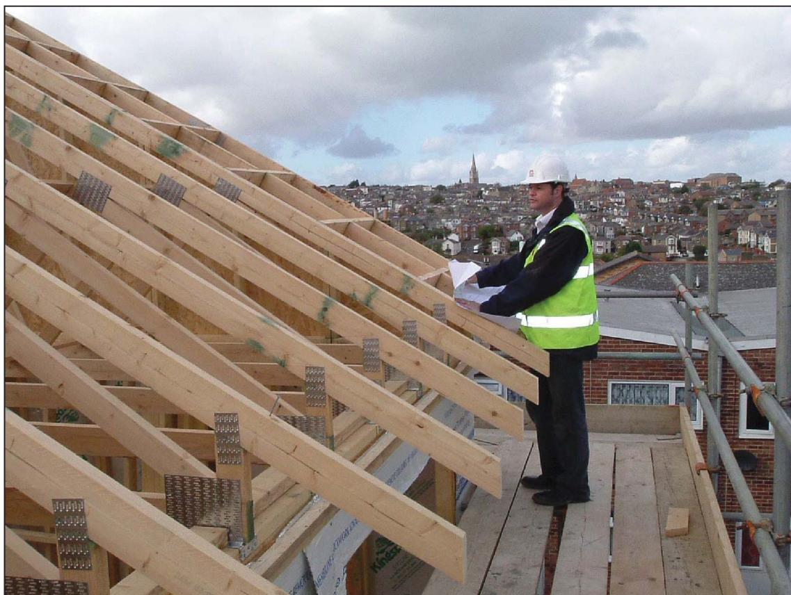
*Fig. 87 Imágenes de apoyo. Protecciones colectivas*
