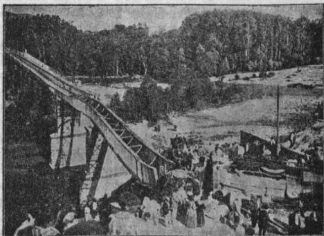
El puente de Montalvo después de la catástrofe
