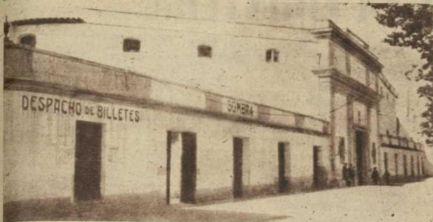
Fachada de la Plaza de toros de Córdoba (Foto Archivo)
