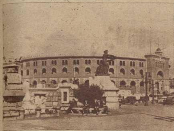
Vista exterior de la Plaza de las Arenas de Barcelona
