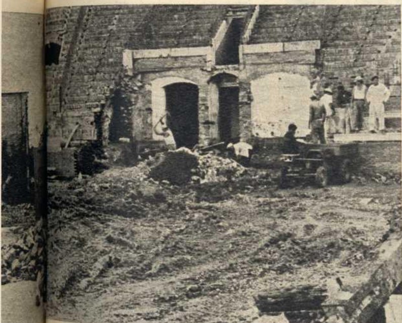
CHIVEROS.—Obras ante el portón de los sustos. Los toriles van a ser totalmente reformados así como la meseta sobre los mismos. FOTOS CERDA
