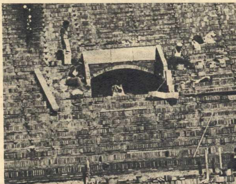
VOMITORIOS.—Cada uno de los vomitorios de acceso al tendido se amplía dos metros en su anchura y se les provee de cómoda escalera.
