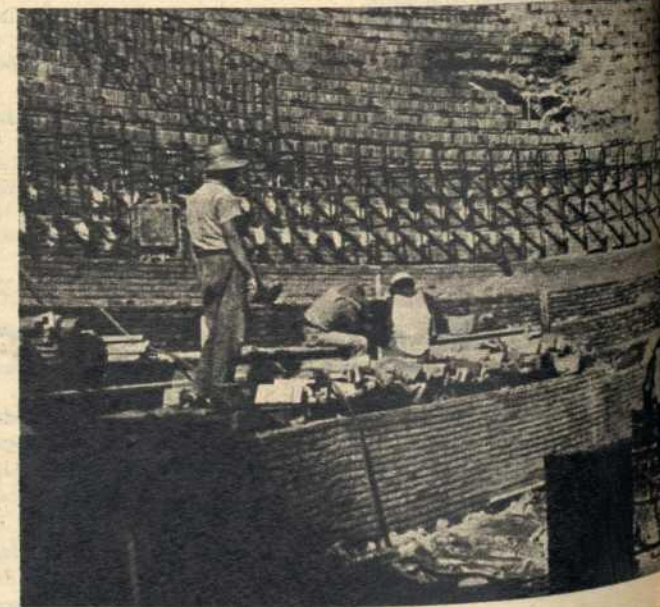
NOVEDAD.—El suelo se rebaja y el ruedo se reduce un poco; en el muro viejo y el nuevo, los albañiles trabajan en las nuevas grad...
