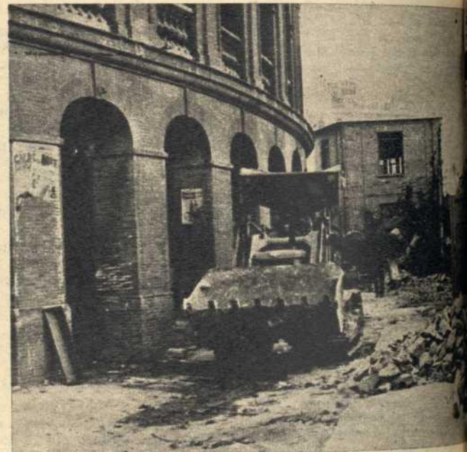
DEMOLIDA.—La muralla que rodeaba la plaza ha sido demolida por tractores oruga, con lo que los accesos ganan vista y holgura.
