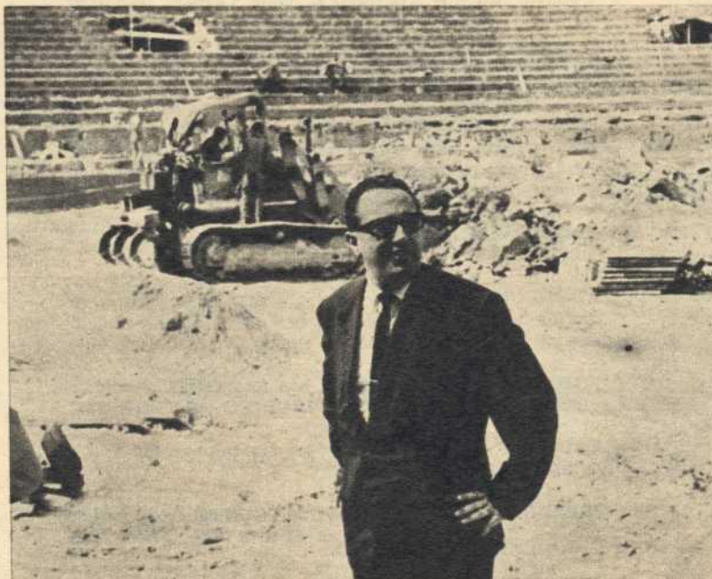
VIGILANCIA.—El señor Alonso Belmonte, desde el centro del ruedo de la plaza valenciana, vigila las obras de reforma y ampliación.
