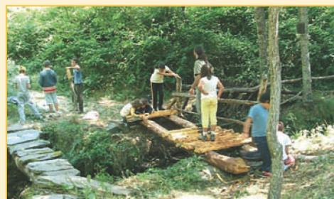
Corta selectiva, desmote y reposición de vigas y travesaños del puente
