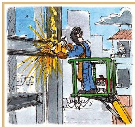
La soldadura TIG puede aplicarse de forma **manual o automática**. En la primera, el soldador controla la dirección y la velocidad de avance. En la segunda, la inclinación del
