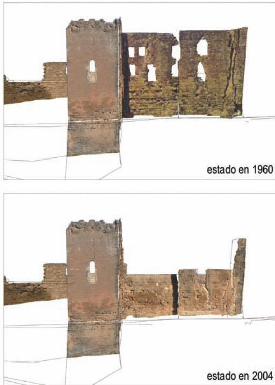
Restitución fotogramétrica de las partes derribadas del castillo de Montearagón en Huesca (Cobos: 2006a)
