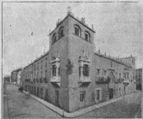
CASA DEL CORDÓN.—Vista general.
