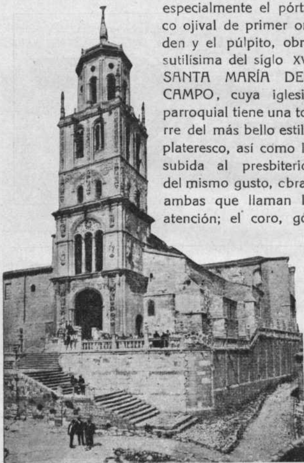
SANTA MARÍA DEL CAMPO. Vista exterior de la iglesia
