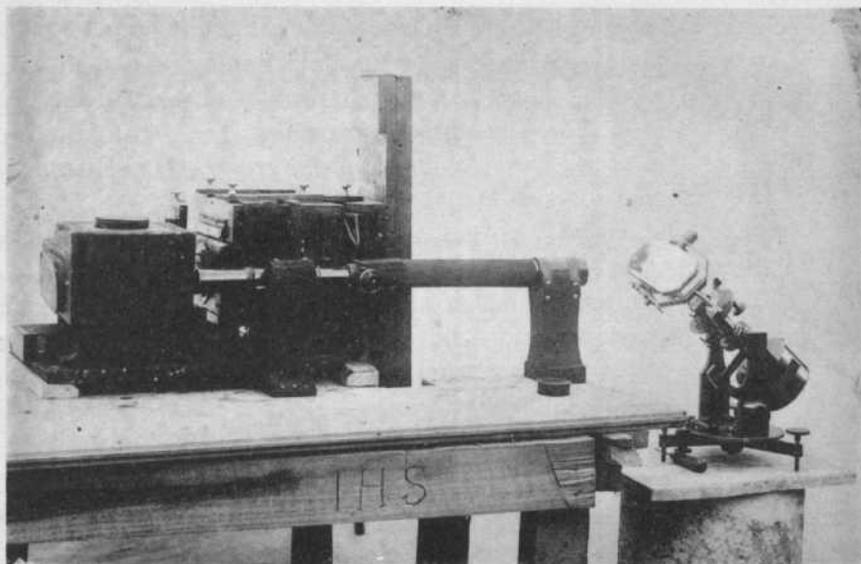
Espectrógrafo y Helióstato
