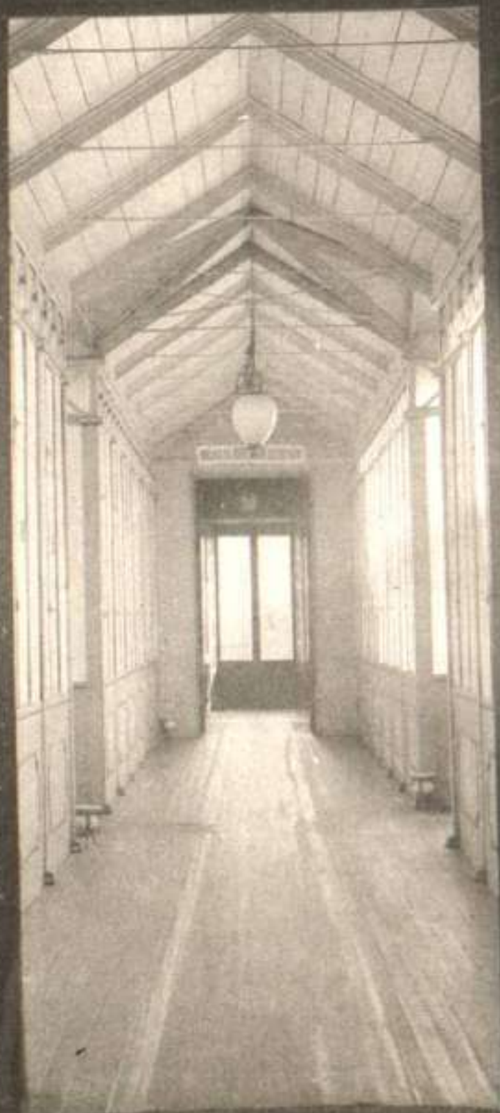
7-VALLADOLID. Academia de Caballería. Paso a Oficinas y Biblioteca
