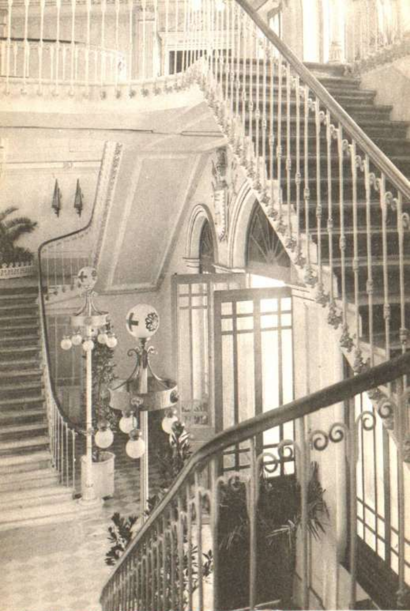
5-VALLADOLID. Academia de Caballería. Escalera principal
