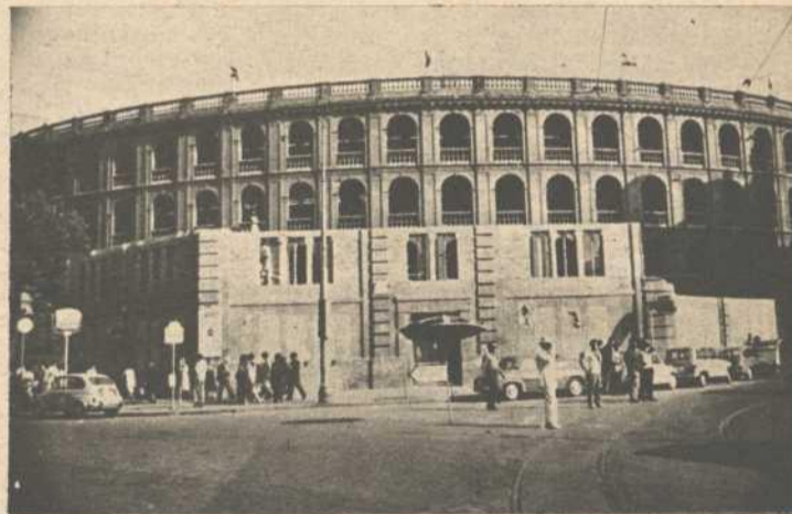
LA FACHADA de la plaza de toros de Valencia ha sido transformada. Como los aficionados recordarán, en el frontal de la misma había instalado un bar. Pues bien; el mismo ha sido demolido y, en idéntico sitio, se ha levantado una nueva edificación que posee una superficie de 180 metros cuadrados, con planta baja y entresuelo.
