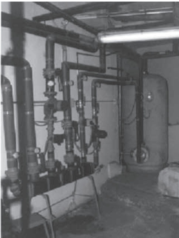
Figura 19. Tuberías de distribución de calor.
