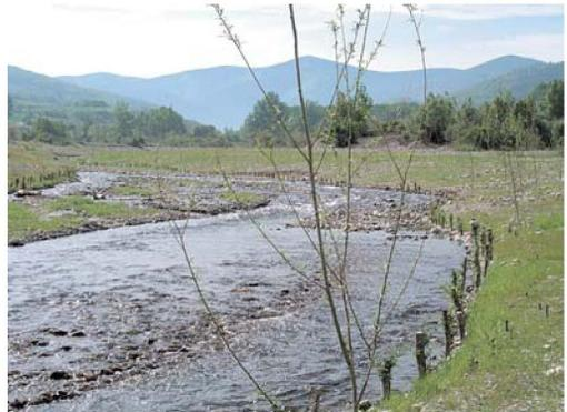
En diversos tramos degradados del río Tirón se han realizado restauraciones del ambiente fluvial, conjugándose la utilización de maquinaria forestal, la aplicación de hidrosiembras o las labores manuales. Con la maquinaria se han suavizado los taludes del cauce y se han remodelado las formas naturales del terreno. Se han implantado empalizadas trenzadas de sauces, contribuyendo a la estabilización de las orillas, y otra vegetación autóctona de especies arbustivas y arbóreas.
