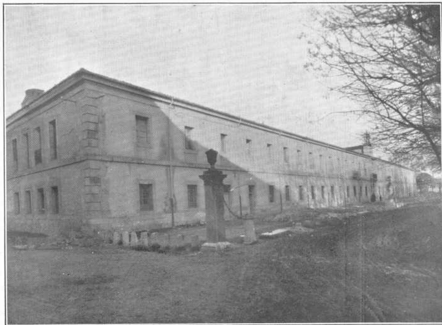
Vista exterior del edificio.
