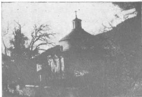
CONVENTO Y REAL CAPILLA DE SAN PEDRO ALCÁNTARA (Fot. Alberto.-Arenas)
