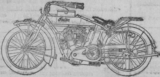
Motocicletas INDIAN.—La mejor del mundo. Modelos de uno y dos cilindros, de 3 1/2, 4, 5 y 7 H.P. y de tipo Hondes Special, con arranque, alumbrado y klaxon eléctrico, contador kilométrico é indicador de velocidad.
