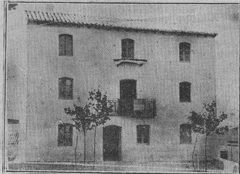
Fachada del nuevo edificio construido bajo el patrocinio de la Junta Técnica en el pueblo de Villamayor del Río y destinado a escuela y viviendas para funcionarios, cuya bendición e inauguración celebrada el pasado martes, fué presidida por el Excmo. Sr. Gobernador civil y jefe provincial del Movimiento. Foto FEDE.
