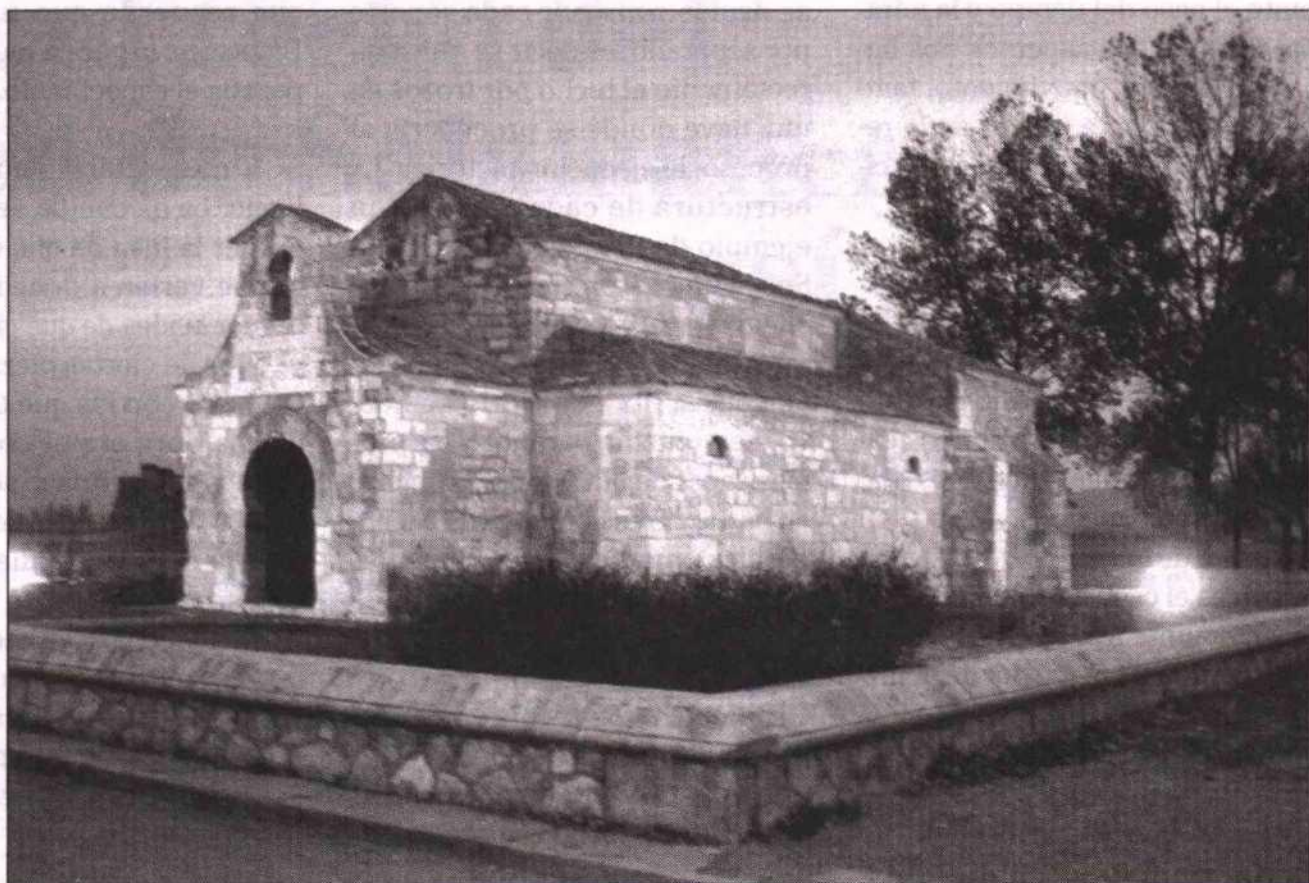
Basilica de San Juan. Baños de Cerrato (Palencia)
