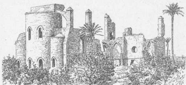
Fig. 82. — Ruines de l'église de Sainte-Sophie, à Famagouste. (Ile de Chypre.)
