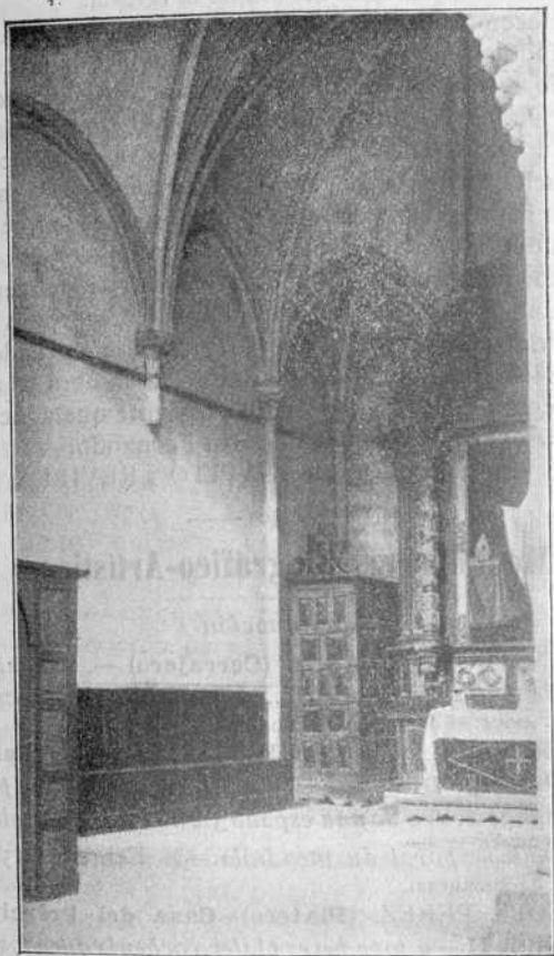
DETALLE DEL ÁNGULO DE LAS BÓVEDAS DE LAS CAPILLAS DEL CRUCERO
