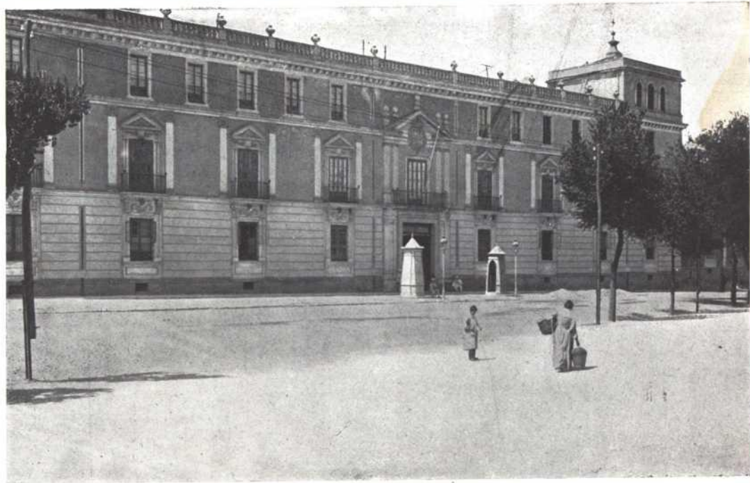
Ocupa el antiguo Palacio Real, edificado á principios del siglo XVII, en cuyo patio principal se observan dos órdenes de galerías estilo Renacimiento
